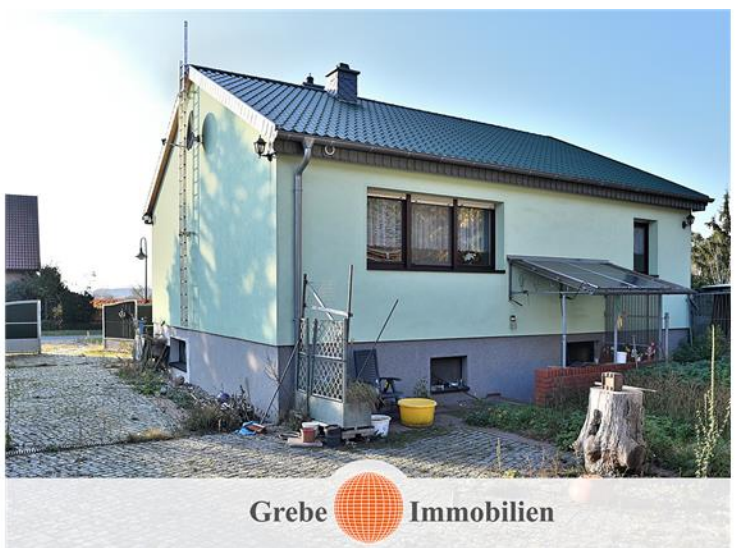
Ansicht von hinten
